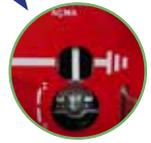
3. ضع عتلة التشغيل في نقطة تشغيل مفتاح فاصل الحمل الكهربائي وقم بشحن النابض عن طريق تدويره عكس اتجاه عقارب الساعة ومن ثم أخرج عتلة التشغيل من نقطة التشغيل
