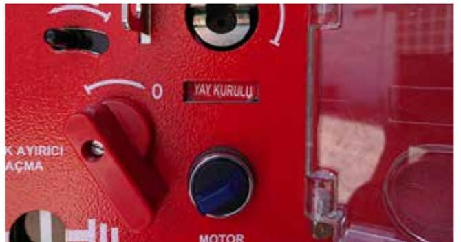
4. قم بتوصيل مفتاح فاصل الحمل الكهربائي عن طريق تدويره إلى الوضع "1"
