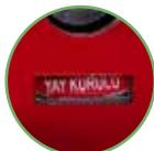
ملاحظة: إذا كان مفتاح فاصل الحمل الكهربائي مزوداً بماتور فتأكد من شحن النابض (لاحظ التعبير "النابض مشحون") عن طريق تدوير مفتاح شحن النابض للماتور باتجاه عقارب الساعة
