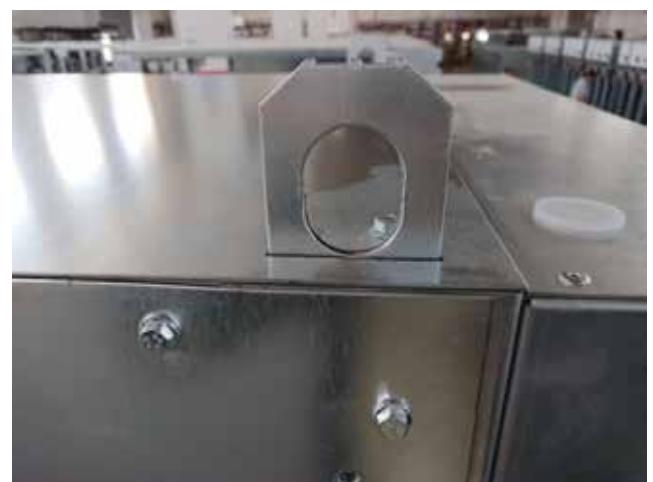
وفقاً لمخطط الدائرة الكهربائية للمنشأة، ادمج الفتحات مربعة الشكل للخلايا جنباً إلى جنب باستخدام برااغي ذي مقاس M8x20
