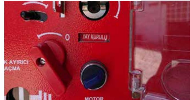
4. قم بتوصيل مفتاح فاصل الحمل الكهربائي عن طريق تدويره إلى الوضع "I"
