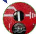
3. ضع عنة التشغيل في نقطة تشغيل مفتاح فاصل الحمل الكهربائي وقم بشحن النابض عن طريق تدويره عكس اتجاه عقارب الساعة ومن ثم أخرج عنة التشغيل من نقطة التشغيل
