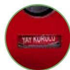
ملاحظة: إذا كان مفتاح فاصل الحمل الكهربائي مزوداً بمطور فتأكد من شحن النابض (لاحظ التعبير "النابض مشحون") عن طريق تدوير مفتاح شحن النابض للمطور باتجاه عقارب الساعة
