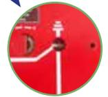
3. ضع عتلة التشغيل في نقطة تشغيل مفتاح فاصل الجهد الكهربائي وقم باغلاقه عن طريق تدويره عكس اتجاه عقارب الساعة
