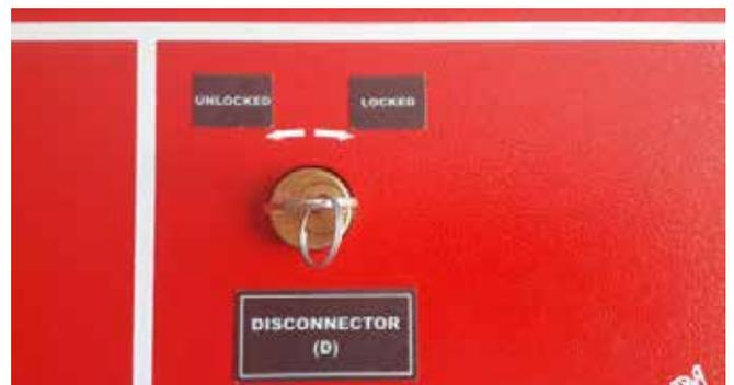
5. قم بفصل فاصل الجهد الكهربائي عن طريق وضع عتلة التشغيل في نقطة تشغيله مدوراً اياه باتجاه عقارب الساعة
