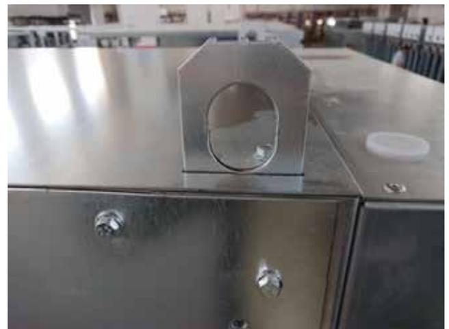
وفقًا لمخطط الدائرة الكهربائية للمنشأة، ادمج الفتحات مربعة الشكل للخلايا جنبًا إلى جنب باستخدام براغي ذي مقاس M8x20
