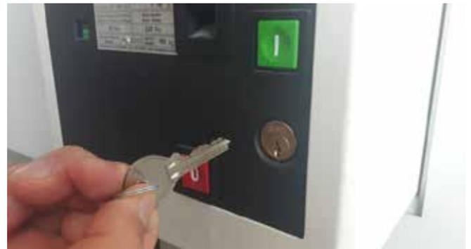
4. أدخل المفتاح الذي تم إخراجها من قفل قاطع الدورة الكهربائية وادخله في قفل فاصل الجهد الكهربائي ثم أدركه عكس اتجاه عقارب الساعة لفتح آلية الفاصل
