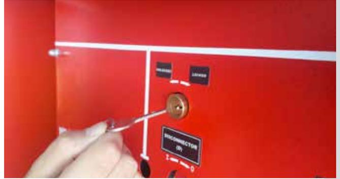
5. أدخل المفتاح الذي تم إخراجها من قفل فاصل الجهد الكهربائي وادخله في قفل قاطع الدورة الكهربائية ثم أدره عكس اتجاه عقارب الساعة لفتح آلية القاطع
