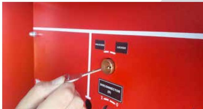
5. Вставьте ключ, вынутый из механизма разделителя, в замок на механизме прерывателя и поверните ключ на часах. РАЗБЛОКИРУЙТЕ механизм, повернув его против часовой стрелки.
