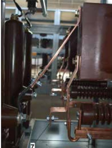
1. Откройте дверцу отсека кабельных соединений в ячейку
