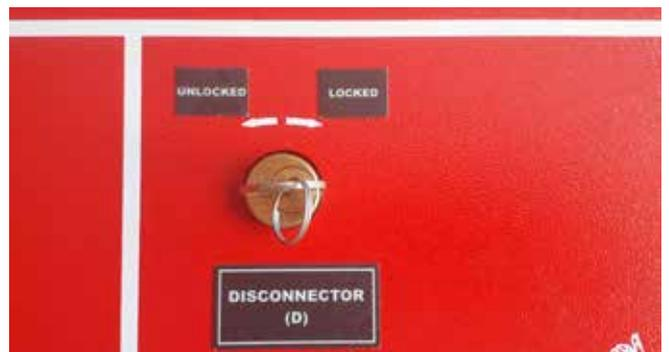
5. Прикрепите рычаг маневра к отсеку для маневра сразделителя и поверните его по часовой стрелке, чтобы открыть разделитель.
