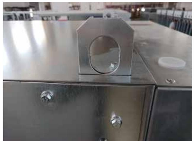
В соответствии с односторонней схемой объекта соедините квадратные отверстия кабин бок о бок с помощью болтов М8х20. См.Рисунок ниже (1).
