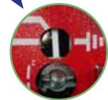
3. Вставьте рычаг управления в открывающийся паз выключателя нагрузки и ЗАГРУЗИТЕ пружину, повернув ее против часовой стрелки. Выньте рычаг открывания из прорези для открывания.
