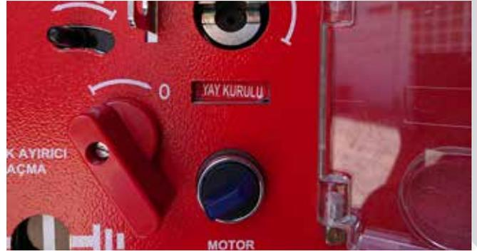
4. ВЫКЛЮЧИТЕ выключатель нагрузки, повернув переключатель опрокидывания в положение "I".
