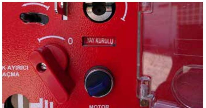
4. Выключите разъединитель нагрузки, повернув открывающуюся защелку в положение «I».
