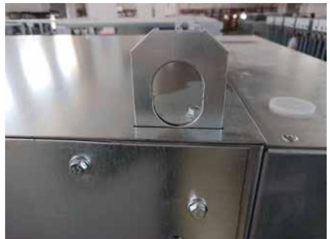
В соответствии с односторонней схемой объекта соедините квадратные отверстия кабин бок о бок с помощью болтов M8x20. См.Рисунок ниже (1)
